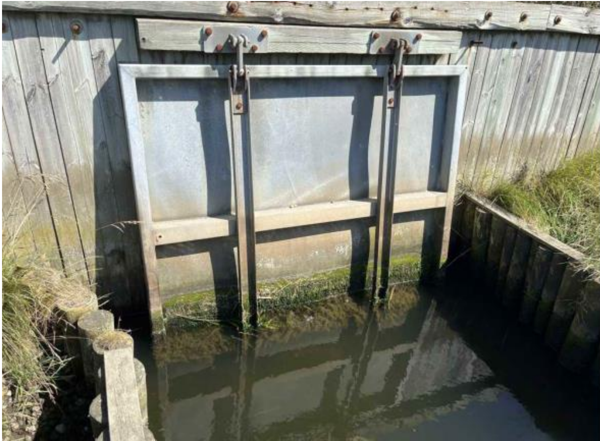
Figur 3: Foto af udløbsside af højvandsslusen i Vestervig Å.
