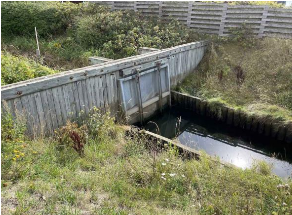
Figur 2: Foto af udløbsside af højvandsslusen i Vestervig Å.
